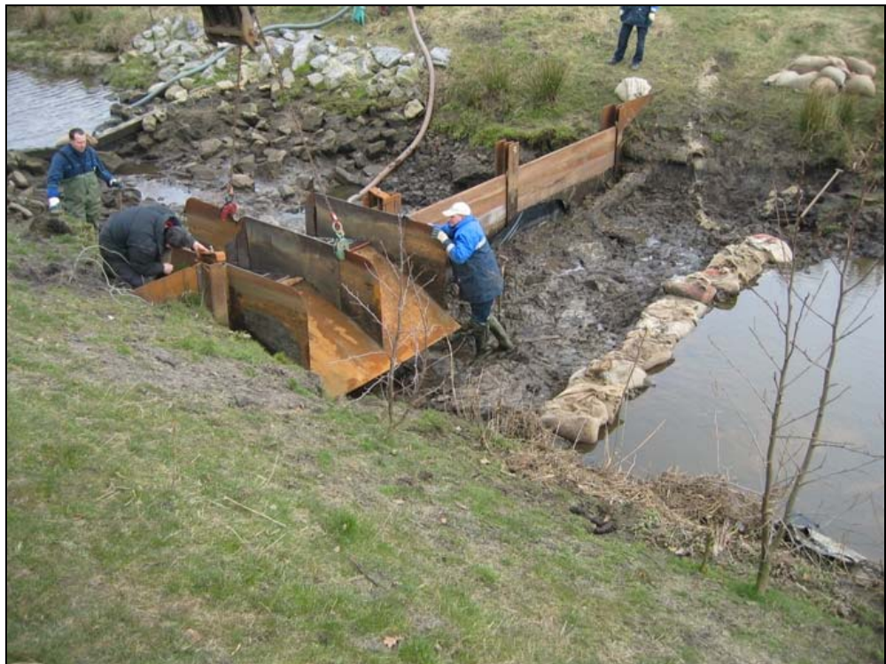
figuur 2.3 Herstelwerkzaamheden aan de FishCounter stuw. .
