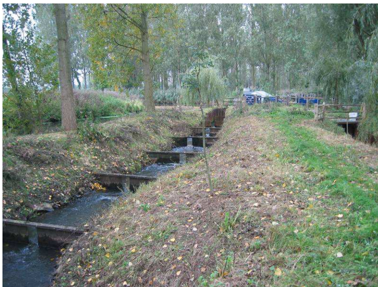
figuur 3.2 De vispassage (na onderhoud)
