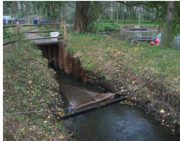
figuur 2.5 Opstelling vangtuig in de vispassage.
