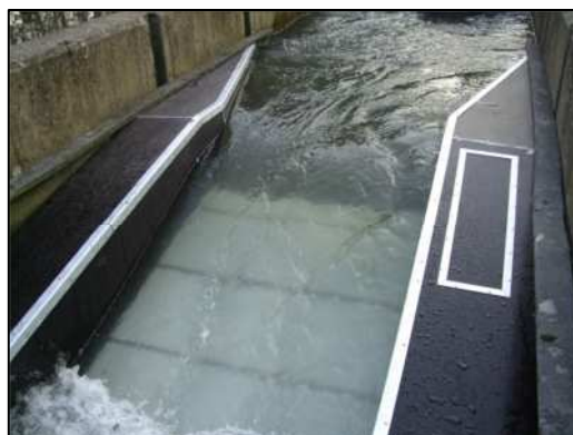
figuur 2.6 Versmalling van de Fish Counter (rood) waarmee het stroomprofiel werd verbeterd.
