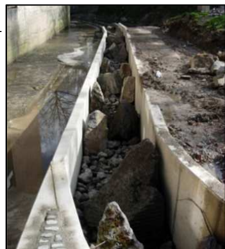
figuur 2.2 Kenmerken (boven) en aanzicht van de vispassage tijdens de bouw (rechts).
