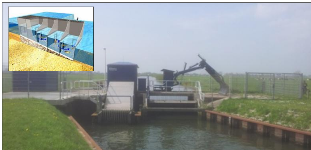
figuur 2.2 Afbeelding van gemaal Kerkeland en het principe van een “de Wit-vispassage” (links boven).
